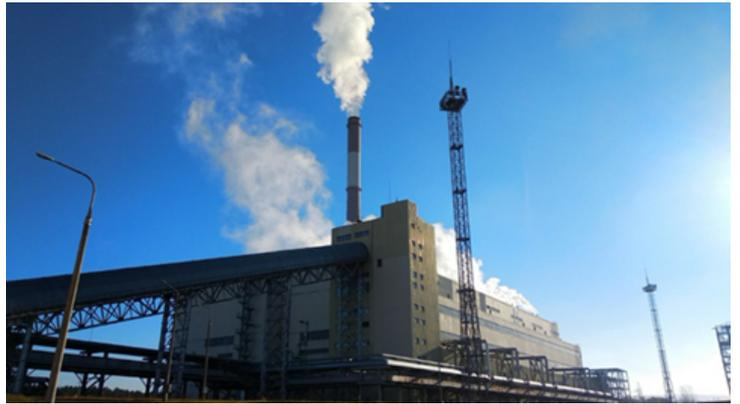
Режимно-наладочные испытания парового котла БКЗ-160-1,4-5 на Железногорской ТЭЦ по сжиганию угольных смесей с разными пропорциями и разными бурыми углями (бородинский, переясловский, большесырский), а также этих же углей по отдельности проводились с 2016 г., и только с 2020 г. станция полностью перешла на сжигание угольной смеси — до этого проектным топливом станции являлся бурый бородинский уголь.
