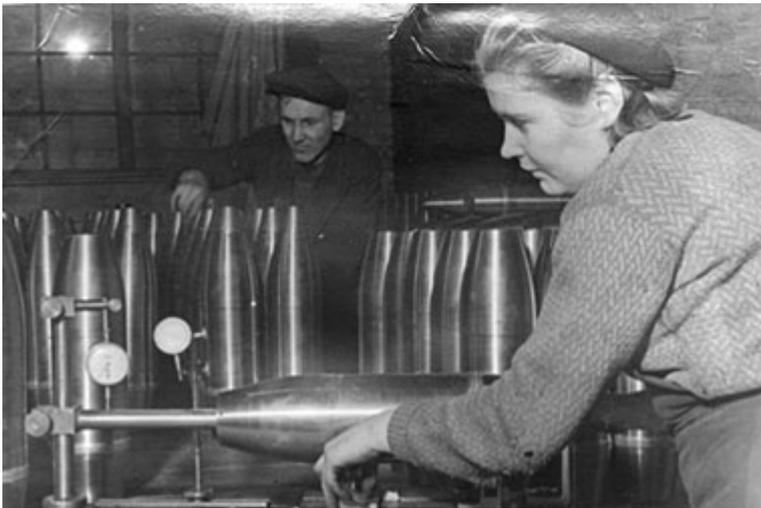
Передовики производства Н-ского завода В. Добрин и П. Горбунов за работой по проверке готовых корпусов снарядов, 1942 год
