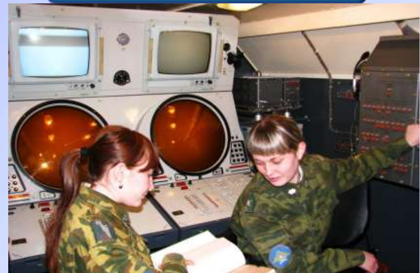
Автоматизированный пункт управления
