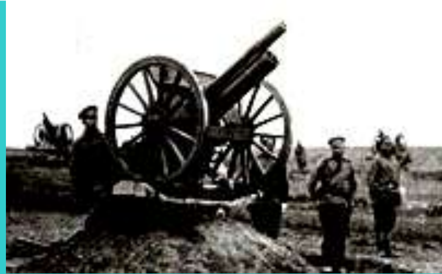
3-дюймовое полевое орудие обр. 1902 г., приспособленное для стрельбы по воздушным целям (1914 г.)
